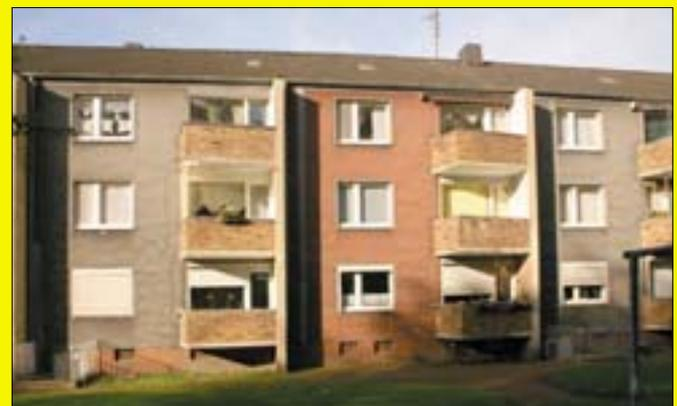
**Zum Bauverein: Die Fassade wird wärmegeklämt und die Häuser 7, 9 sowie 11 erhalten neue Balkone.**
