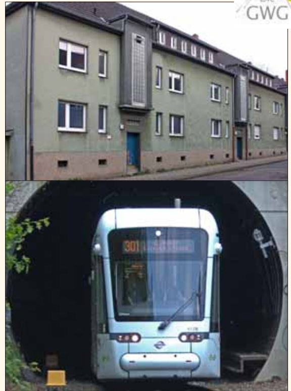
Oben die Abriss Häuser Pönsenstraße, unten die Stadtbahn Gelsenkirchen. Ein Gutachten klärte jetzt, dass der Abriss problemlos ist.
