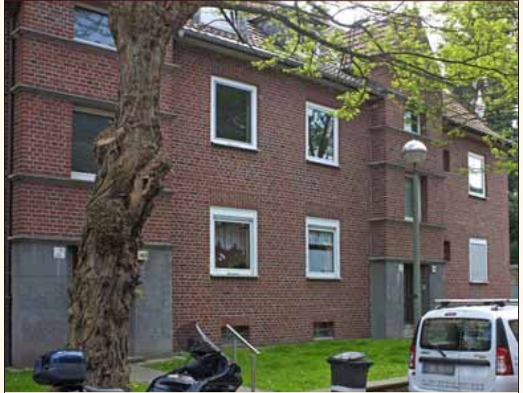
Blick auf den Markgrafenhof in Ückendorf: Die Häuser 38 - 44 werden von der „Die GWG“ aufgewertet.
