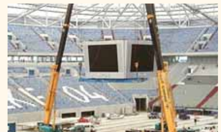
Auch im Videowürfel auf Schalke steckt Abimex Glasfasertechnik.
