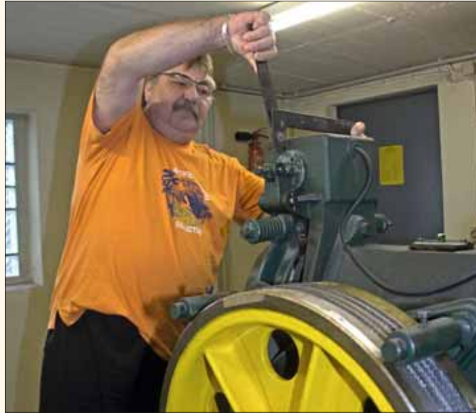
Werner Sobottka zeigt, wie im Notfall der Fahrstuhl manuell bis zum nächsten Ausstieg herabgelassen wird.
