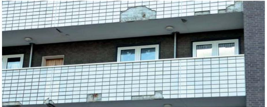
Die Bilder von den sichtbaren Schäden an den Laubengängen und Fassaden sprechen eine deutliche Sprache - die Sanierung war erforderlich. Als in der Memeler Straße 10 dieses Fassadenstück (unten, auf einem Tisch liegend) auf die Wiese fiel - zum Glück war niemand
