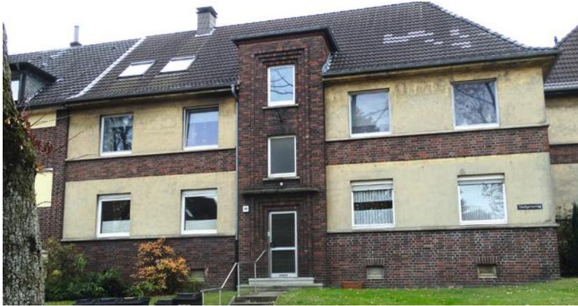
Die Fassaden der Häuser bleiben im Kern erhalten. Die Klinker werden abgestrahlt, die darüber liegende Fläche neu verputzt und dann gestrichen. Erneuert werden die Haustüren und die Briefkastenanlagen. Erstmals eingebaut werden Gegensprechanlagen.
