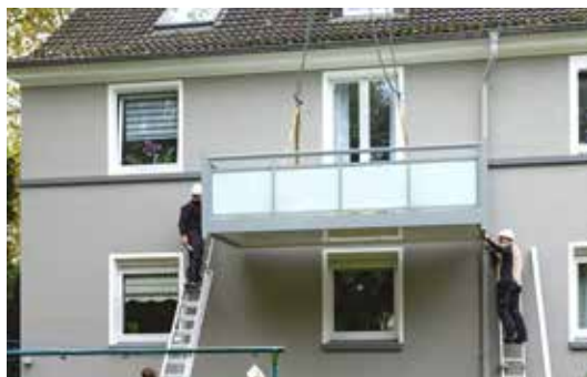
So große Balkone, wie sie beim Schalker Bauverein angebaut werden (Bild bei der Montage) erhöhen den Wohnwert erheblich.
