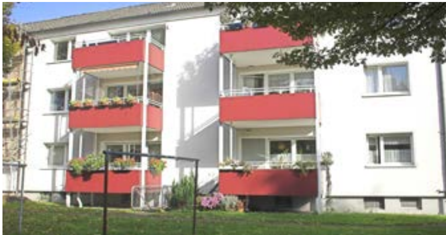
Gepflegter Bestand: Ein Haus der WBG Horst, hier in der Markenstraße.
