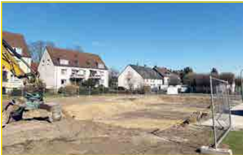
Neu gebaut wird nun auch am Hirschweg 2 in Wattenscheid-Höntrop. Das Fundament wurde bereits ausgekoffert.
